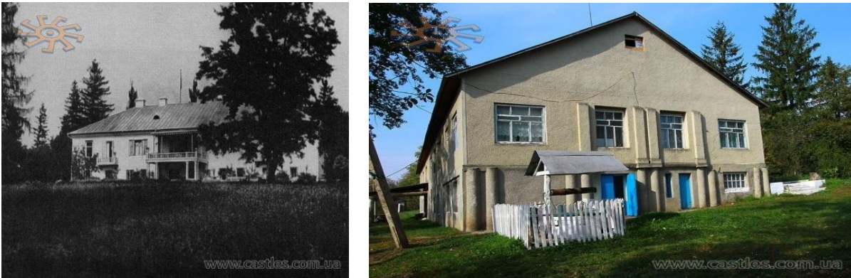
Колишня садиба – теперішня нефункціональна школа
